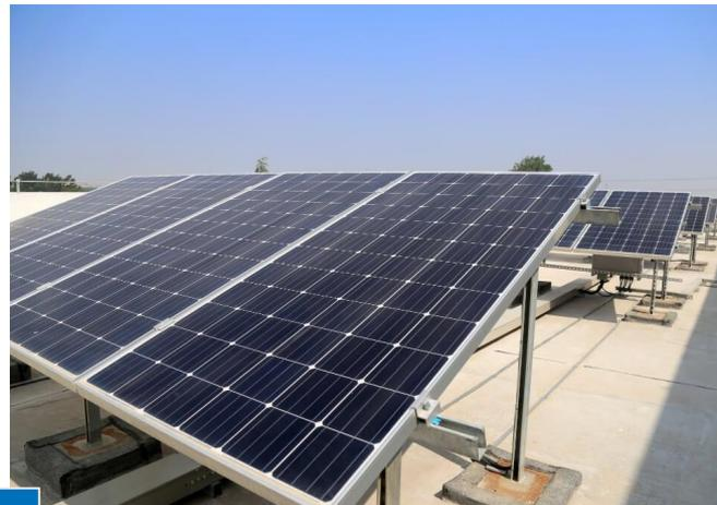
Concrètement, avec le principe de l'autoconsommation collective, les panneaux solaires installés sur le toit de la copropriété produisent de l'électricité, qui sert à alimenter les parties communes ou les logements, selon une répartition prédéfinie.
