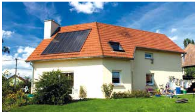
Les panneaux solaires thermiques peuvent alimenter un système de chauffage.
